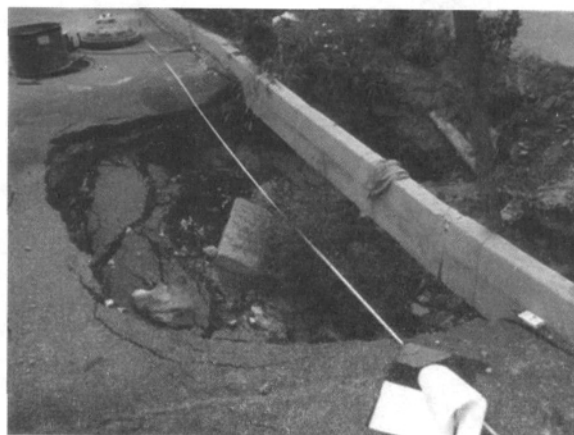
图 2 塌陷造成的破坏
