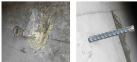
图5 缺陷打孔处理及二次补浆示意图
