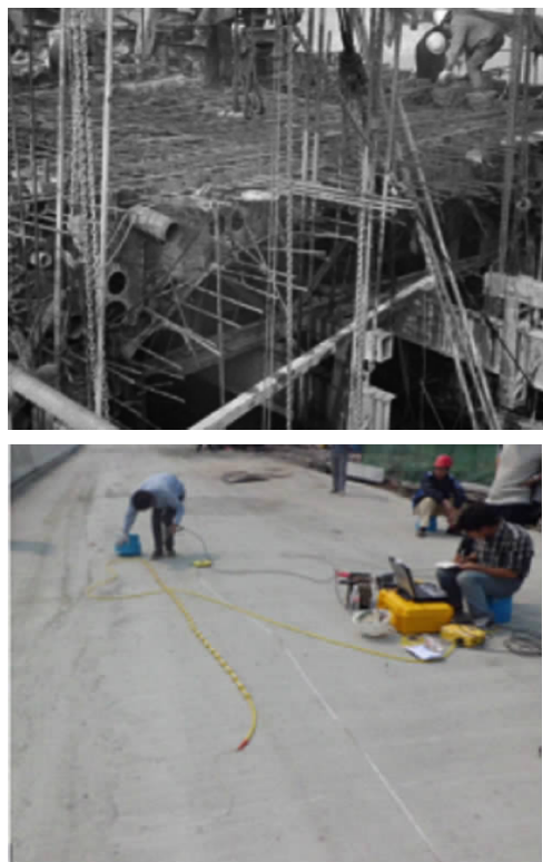
图 3 现浇梁的预应力孔道情况(上)和检测施工现场(下)实景
