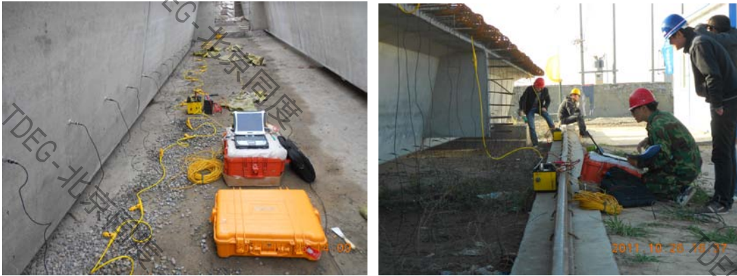
图1.1 桥梁预应力管道注浆质量检测现场
