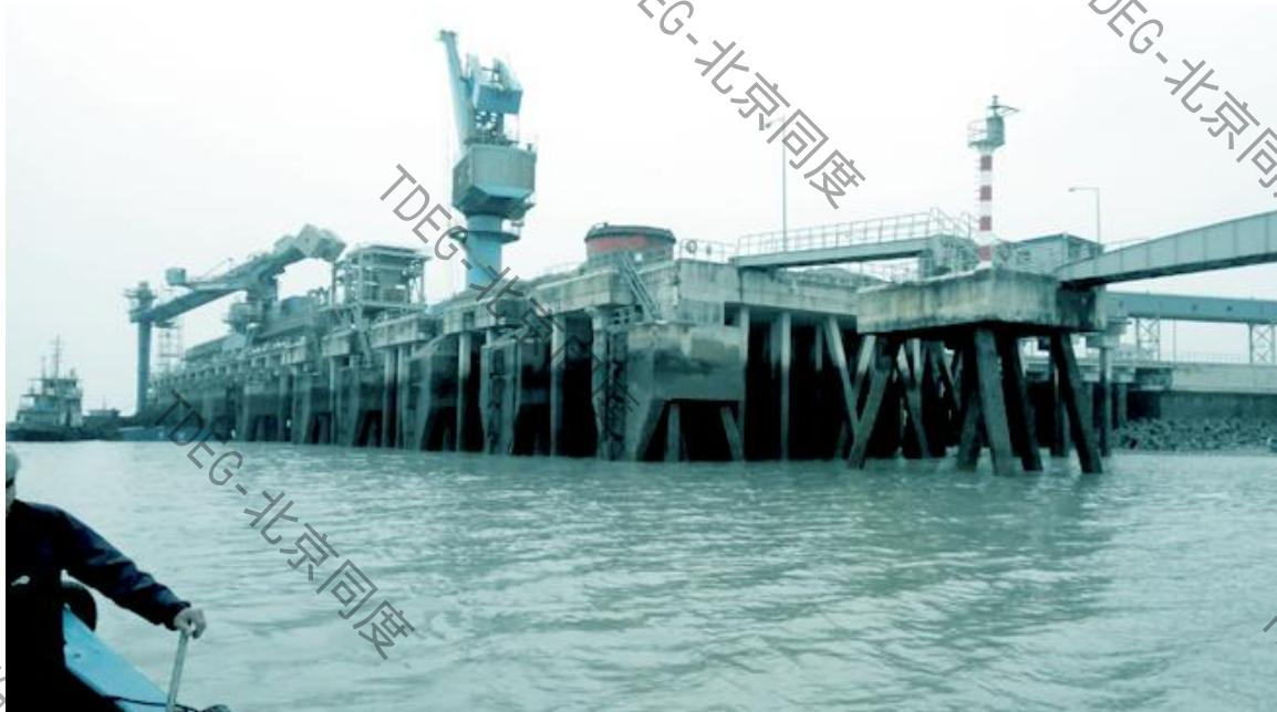
桥梁与桩基常规的检测方法如外观检查、回弹检测和小应变等方法都不能胜任该类具有上部结构的桩体的检测。受某电厂的委托，北京同度物探技术有限公司和福建省建设工程物探试验检测中心采用 PST 成桥桩检测技术对被撞桩体的水下部分进行检测，和应用 CT 技术对桩体上部受损部位进行检测，以便对桩体修复提出建议。
